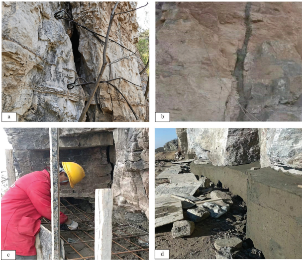
a—锚索锚固;b—裂缝胶结;c—支撑嵌补施工;d—嵌补体成型。
